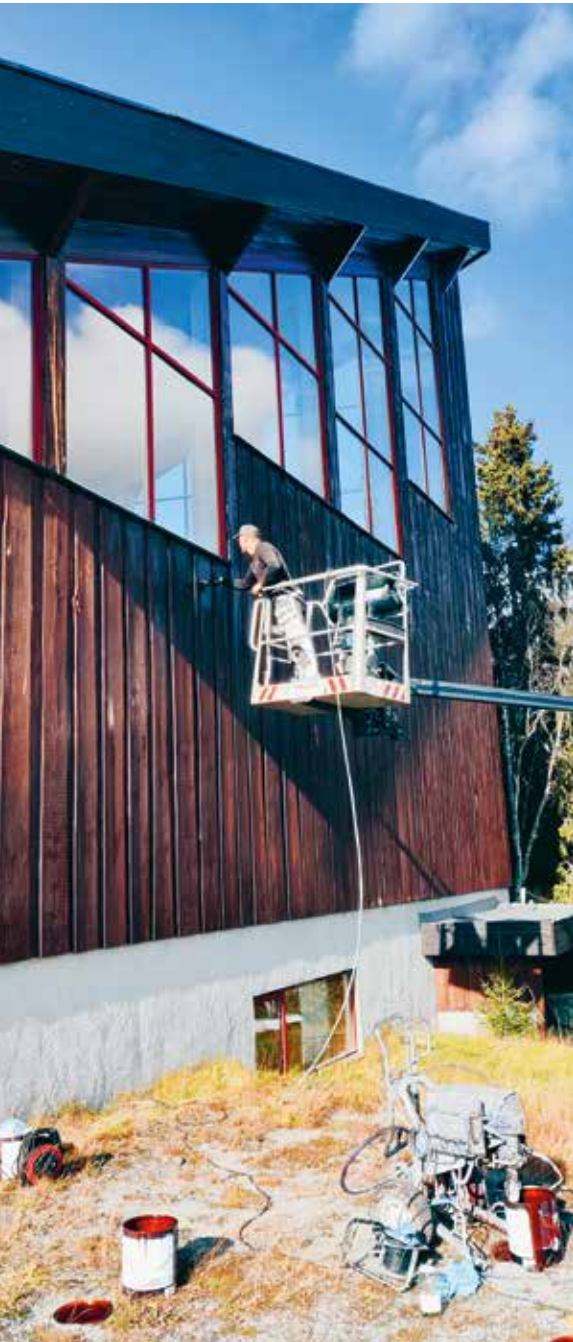
Veggen er høy og stor lift må til. Foto: Didrik Hjort.
